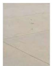
Asphaltte en partie haute du socle
