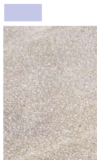
Béton désactivé plus lisse de l'esplanade Cottin
