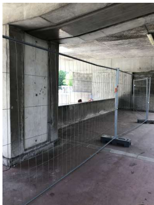
Chantier à l'Est de la tour
