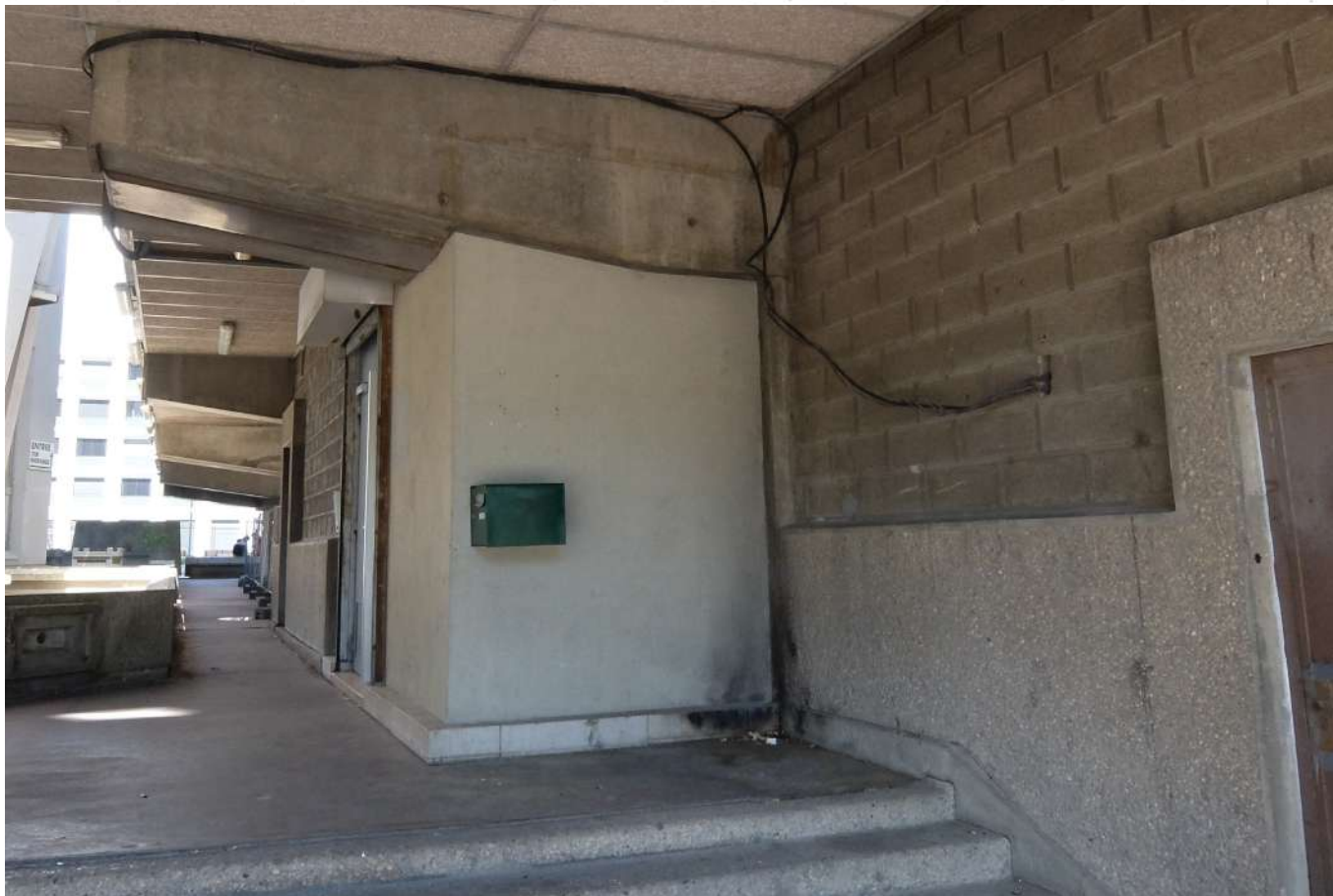
Occultation des halls avec des agglomérés enduits
