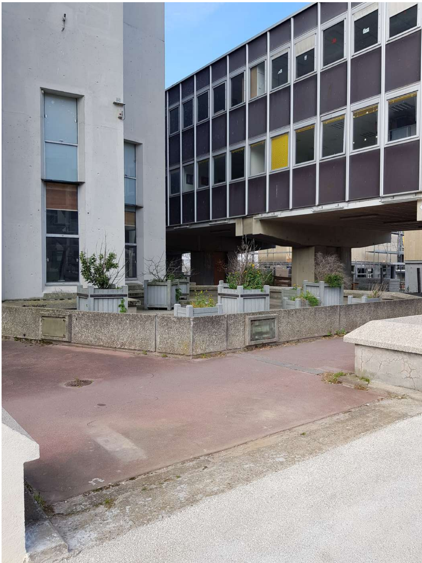
Marches découpées au Nord de la tour pour rattraper l'espace public
