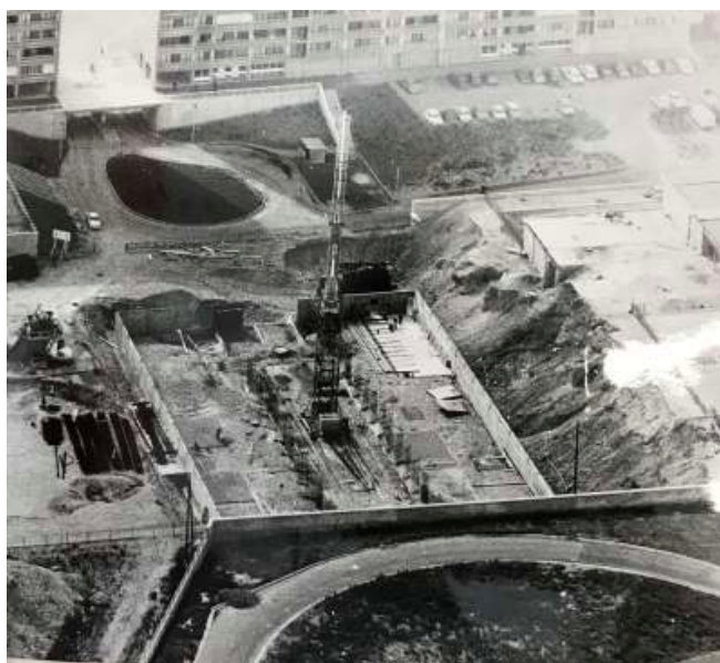
Photos du chantier de la tour, 1972 - réalisation des fondations et du radier
