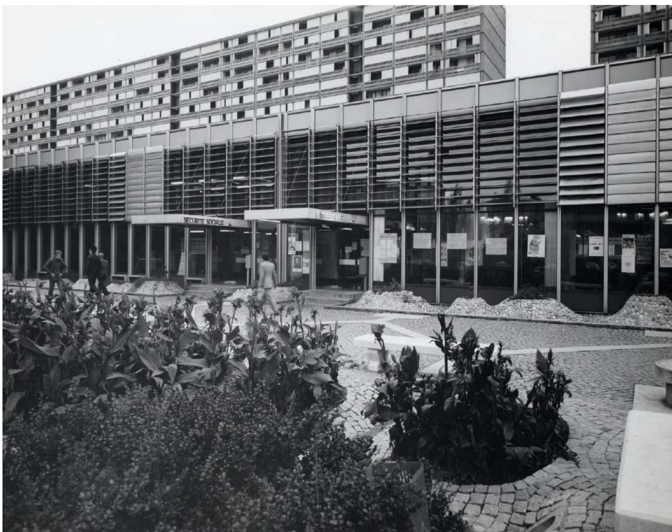
Bâtiment des services publics - façade EST. Brise-soleil de type Jean Prouvé
