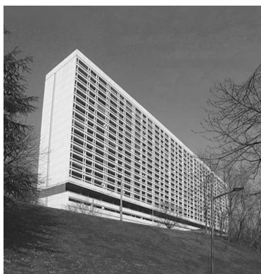
Immeuble les Erables
