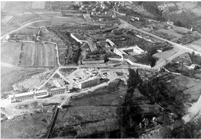
Construction du lycée la Martinière
