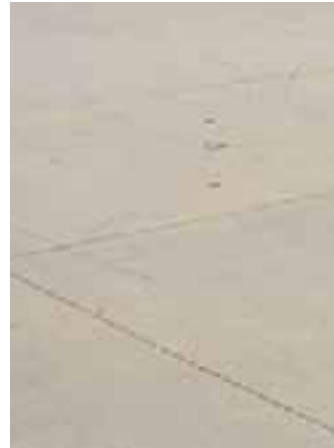
Asphalte en partie haute du socle
