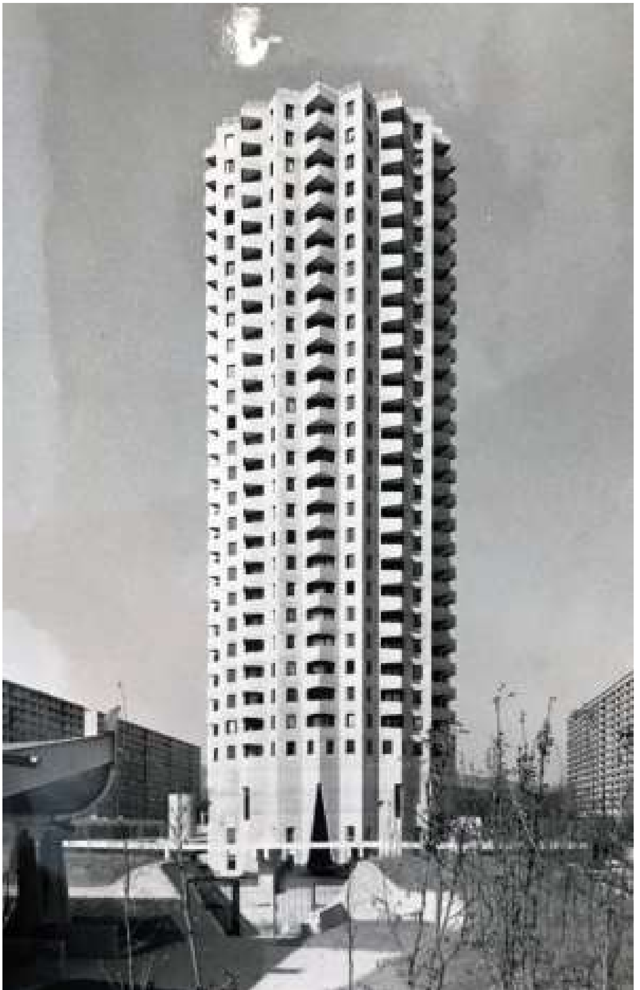
Photos fin du chantier de la tour et en attente du chantier du U, 1972
