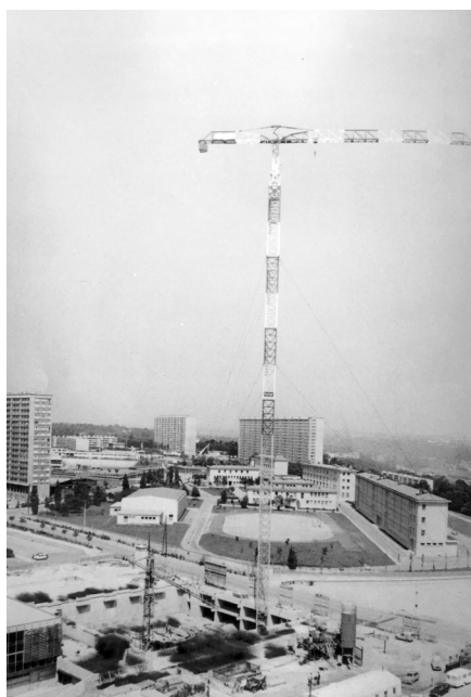
Construction des parkings
