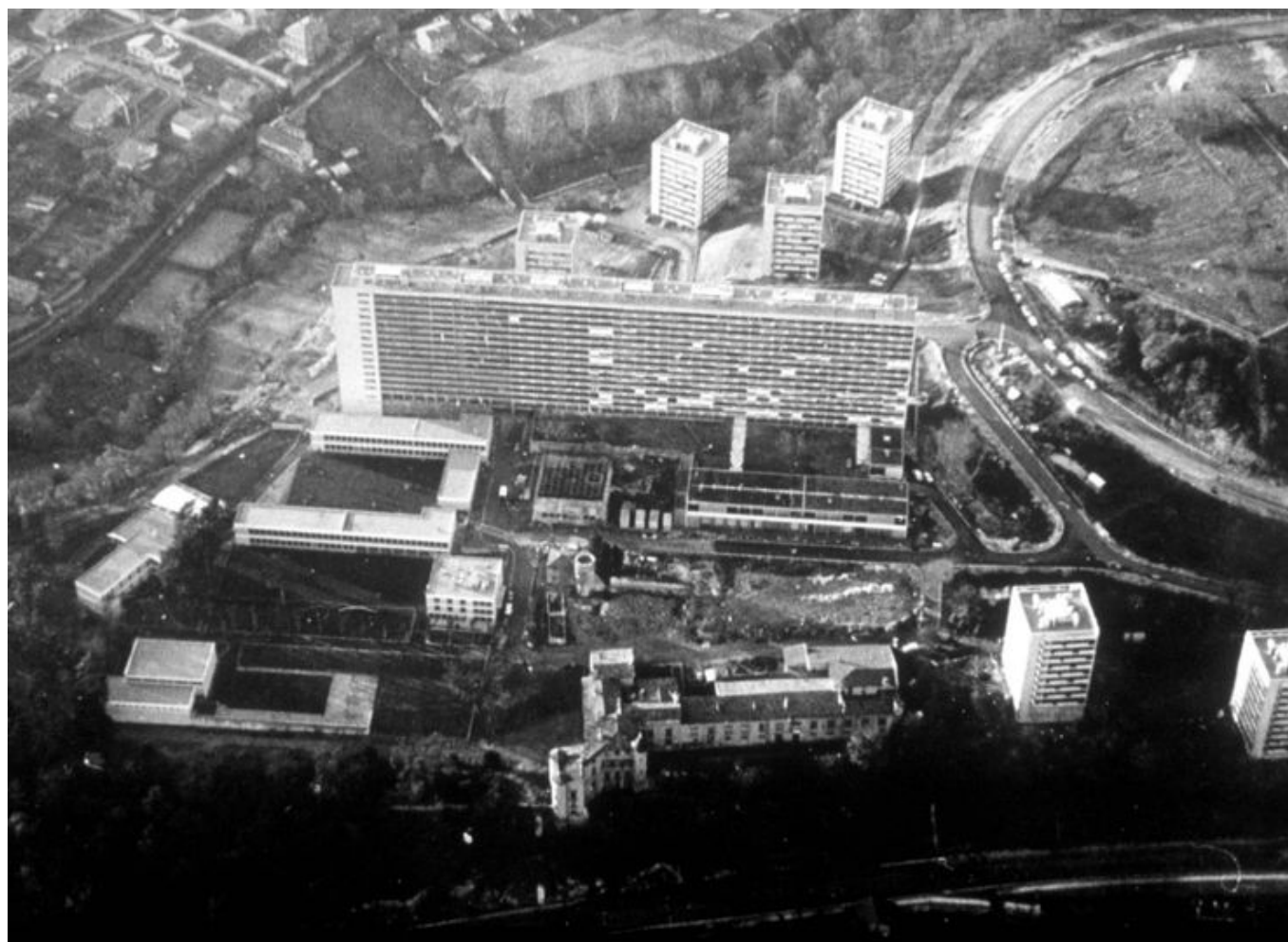
Le quartier du château est le premier à sortir de terre. Le château est détruit en 1973.
