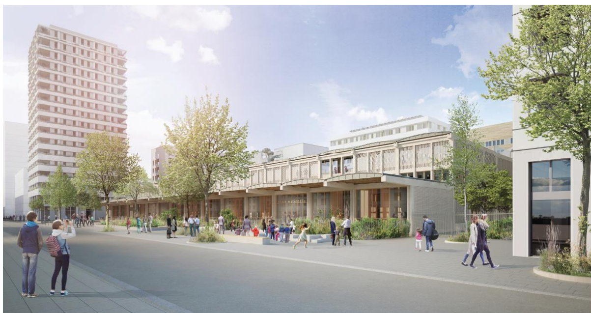
Vue depuis la rue Delandine
