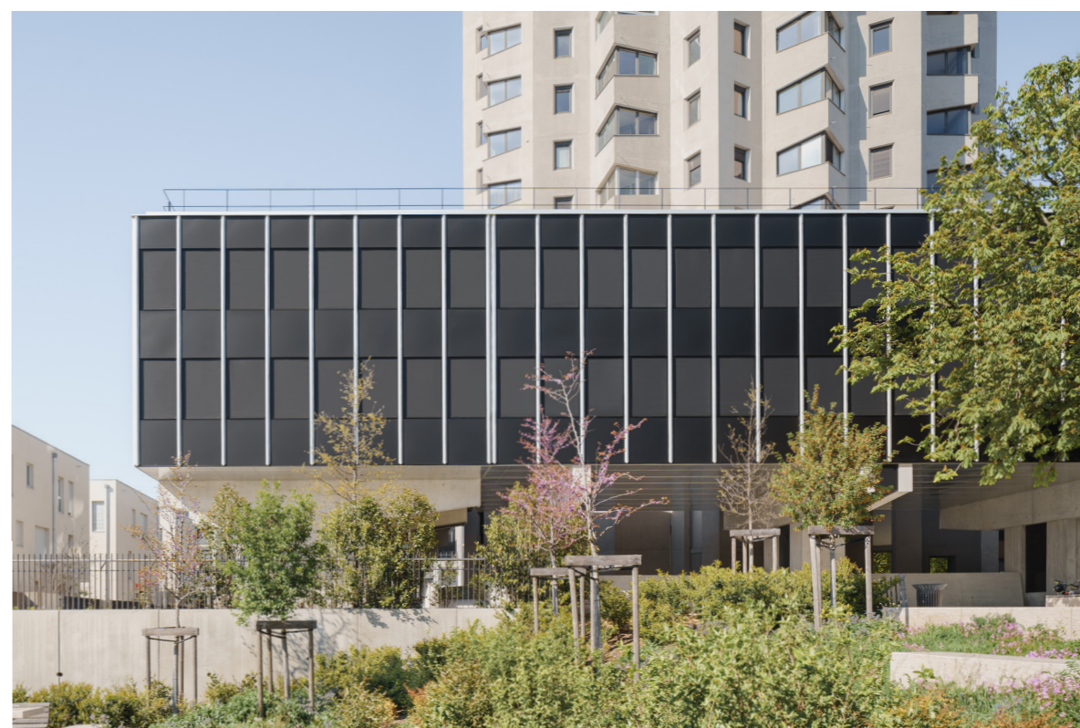
La façade rideau renouvelée
