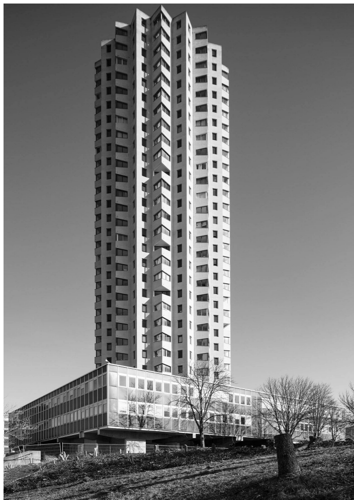
Photo historique et vue générale avant réhabilitation du U
