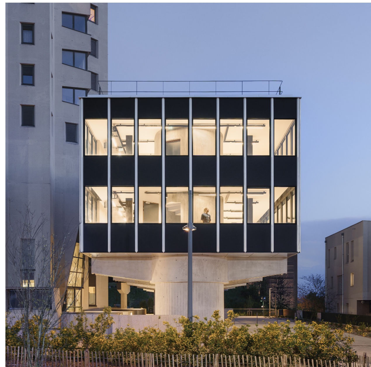
Vue nocture - La façade restaurée et les plateaux libres
