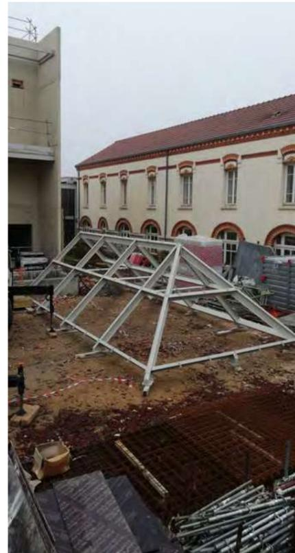
Charpente métallique de la verrière avant levage
