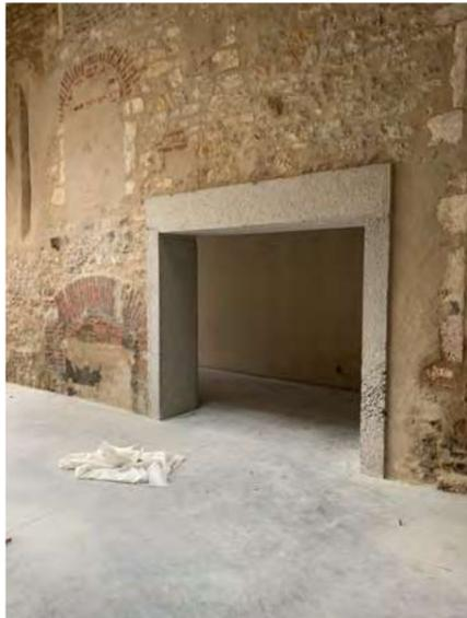
Ouverture en sous-œuvre en béton bouchardée
