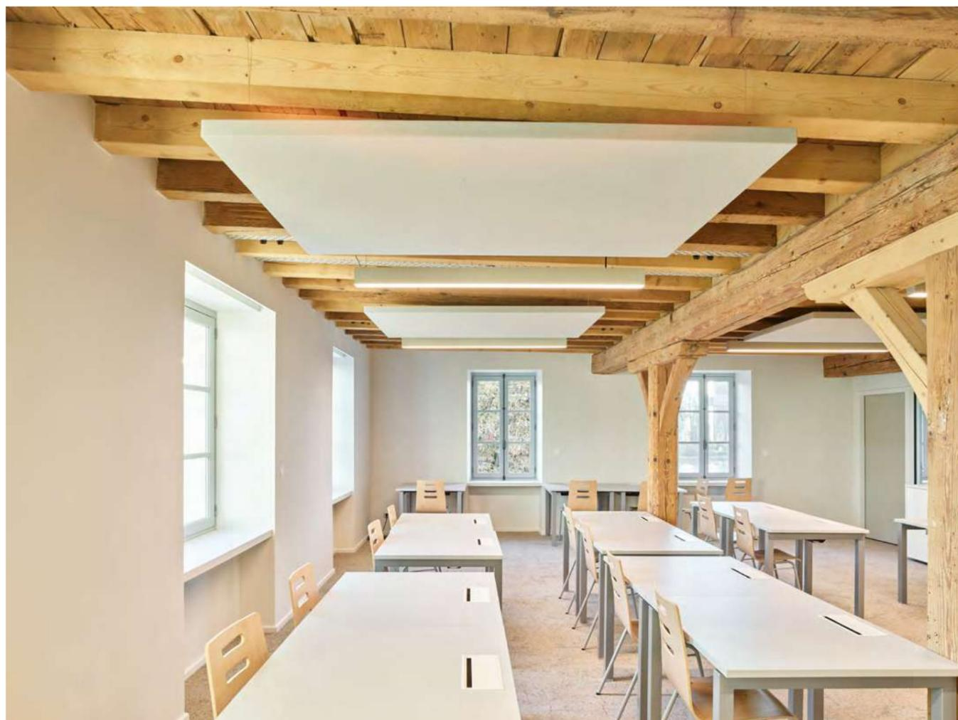
Des structures réparées et des planchers renforcés [connexion bois-béton]
