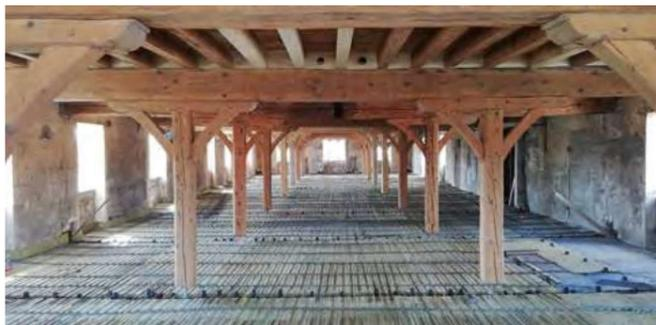
Ferrailage avant coulage de la dalle béton (12cm) connectée aux poutres bois
