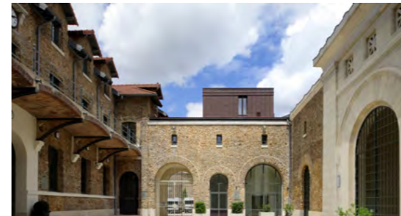
Maison d'arrêt de Paris la Santé [75] Réhabilitation et reconstruction de la Maison d'arrêt de Paris la Santé pour 800 places à Paris Maîtrise d'ouvrage (partenaire privé) : Quartier Santé Constructeur mandataire : VINCI Affectataire : Ministère de la Justice - direction de l'Administration Pénitentiaire Surface : 45 000 m 2 SDP Montant des travaux : environ 100 M€ HT (hors démolition, remblaiements, fondations spéciales)
