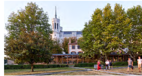
Campus Ecam Lyon [69] Étude de programmation et de définition du campus Ecam 2025. Extension et surélévation de bâtiments d'enseignement et d'un restaurant scolaire Maîtrise d'ouvrage : ECAM Lyon Surface bâtiments livrés : 18 245 m 2 SDP Montant des travaux : 31,5 M€ HT
