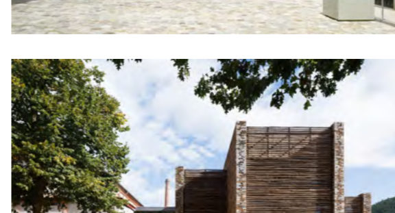
Musée des Vallées Cévenoles à Saint-Jean-du-Gard [30] Réhabilitation et extension d'un ancien bâtiment industriel, la filature Maison Rouge, inscrite à l'inventaire des monuments historiques, pour le transfert du Musée des Vallées Cévenoles Maîtrise d'ouvrage : Alès Agglomération Surface : 3 330 m 2 SDP (1 620 exist. + 1 610 ext.) Montant des travaux : 8,58 M€ HT [compris scénographie]
