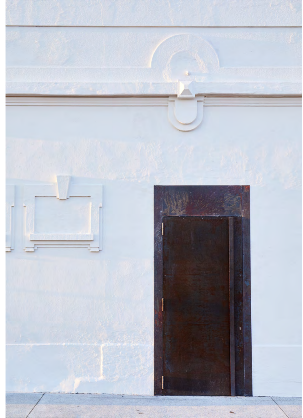
Détails de la façade nord
