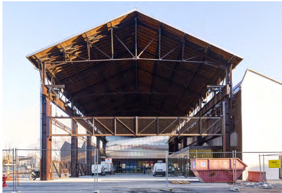
La nef centrale. halle ouverte, nouvel espace événementiel
